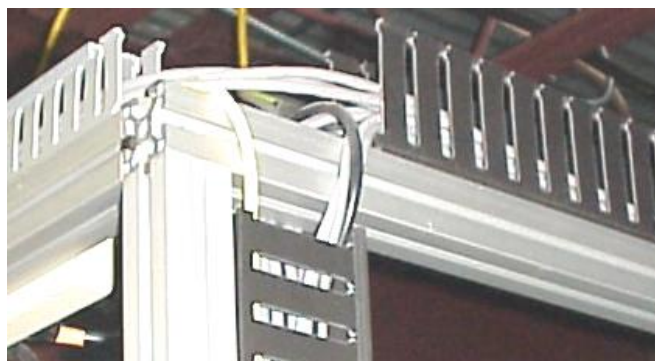
Abb. 24: Kabelkanäle
